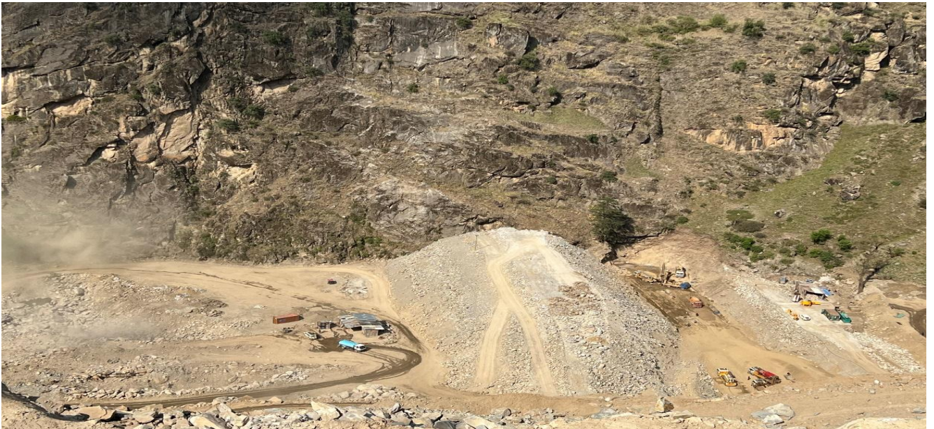
नदी अपवर्तन के पश्चात अपस्ट्रीम कॉफ़र बांध में जारी निर्माण कार्य
