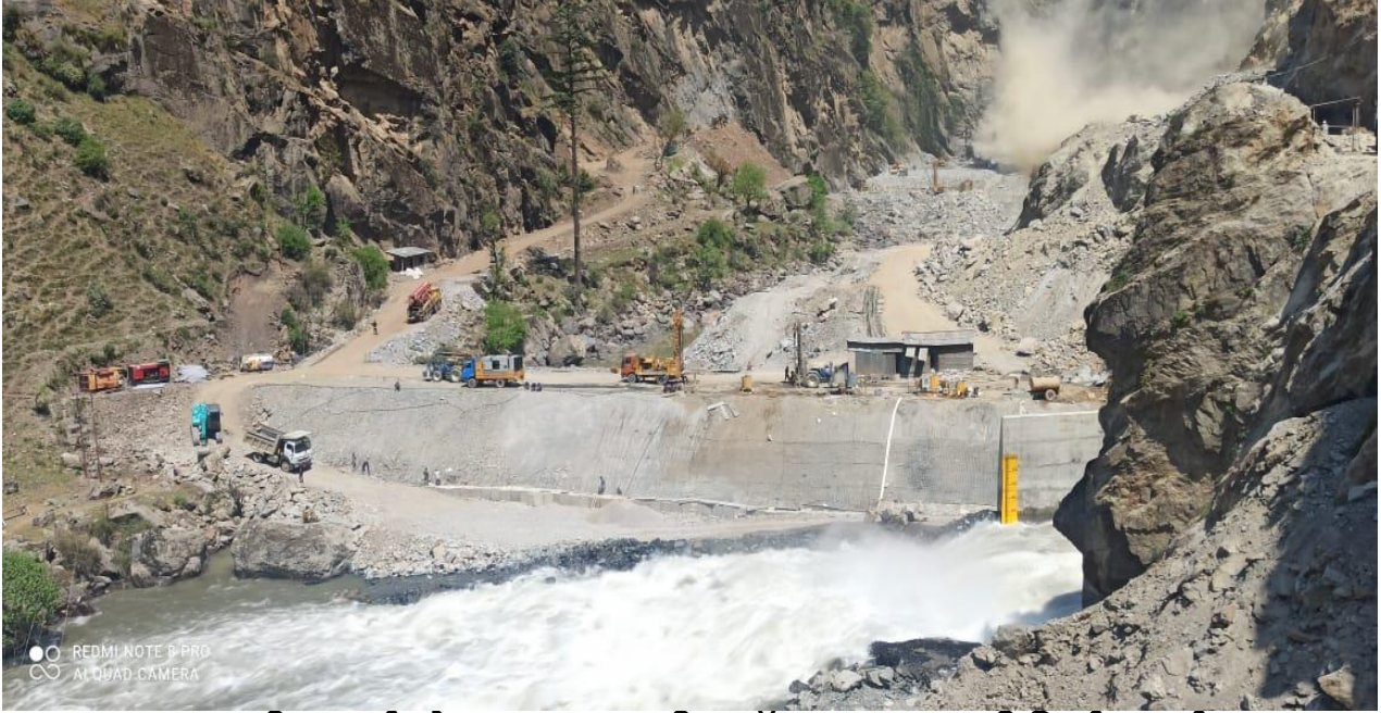
नदी अपवर्तन के पश्चात डाउनस्ट्रीम कॉफ़र बांध पर जारी निर्माण कार्य
